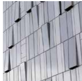
Dominique Perrault Architectes, Paris, (FR) bureaux « Onix » Lille, (FR)
